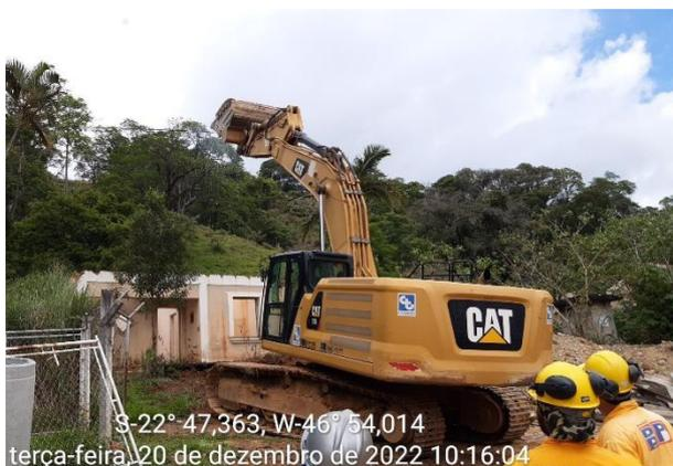
**Foto 13** – Maquinários para a demolição das estruturas. (Data: 20/12/2022).
