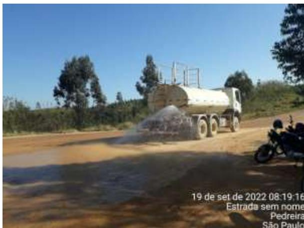
**Foto 1** – Umectação da via MD03, para amenizar os efeitos da suspensão de poeira no local. Data: (19/09/2022).
