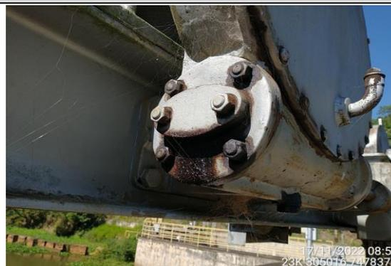
Foto 4 - Estrutura do barramento com graxa.
